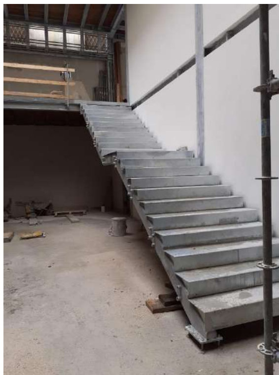
Fotografia che mostra la scala, ancora in fase di lavorazione, che dall'area dell'ingresso dal civico 114, condurrà al livello superiore.
