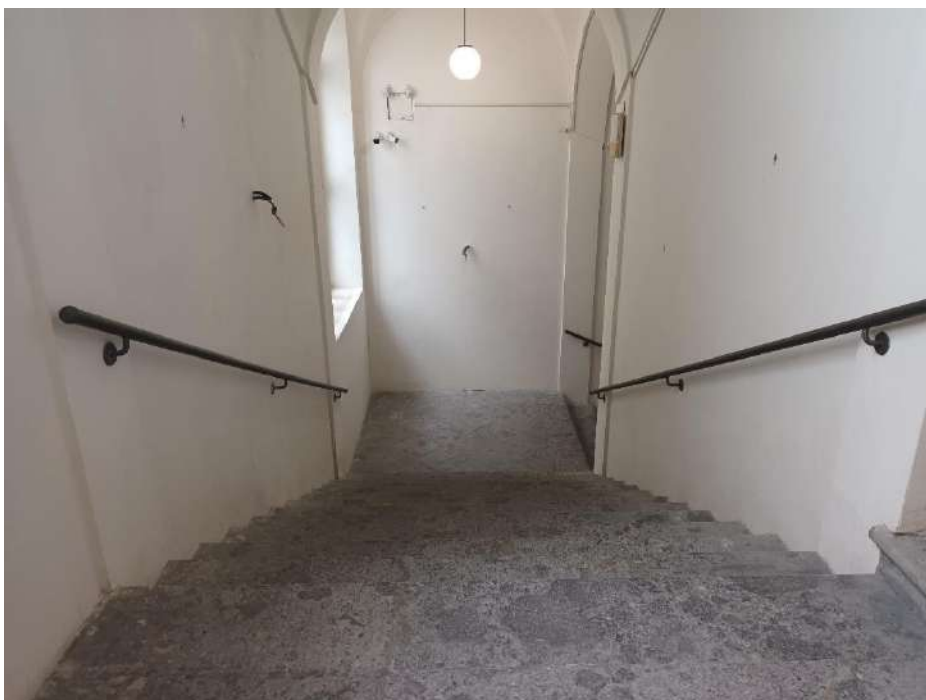
Immagine che mostra la seconda rampa di gradini vista a scendere con visibili i corrimani su entrambi i lati
