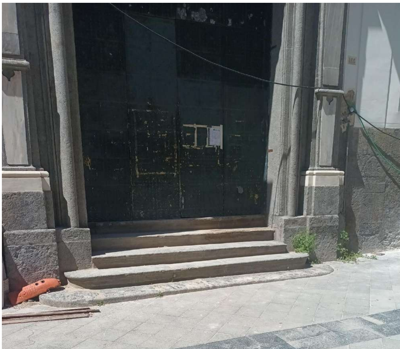
Immagine che mostra la rampa di gradini e la porta
