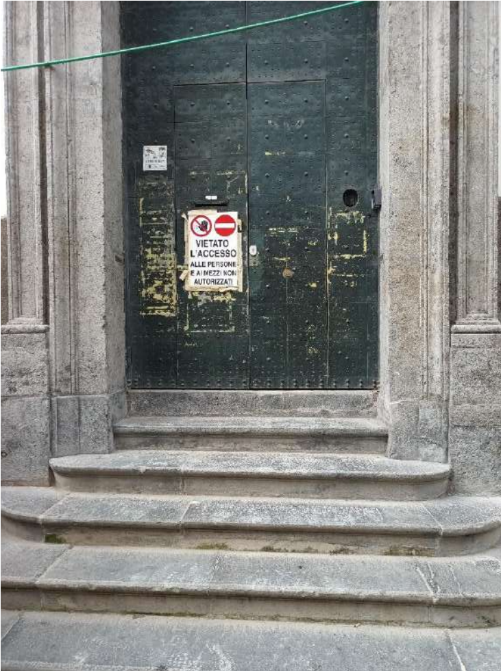
Immagine che mostra i gradini e la porta di accesso al civico 142 di via Duomo
