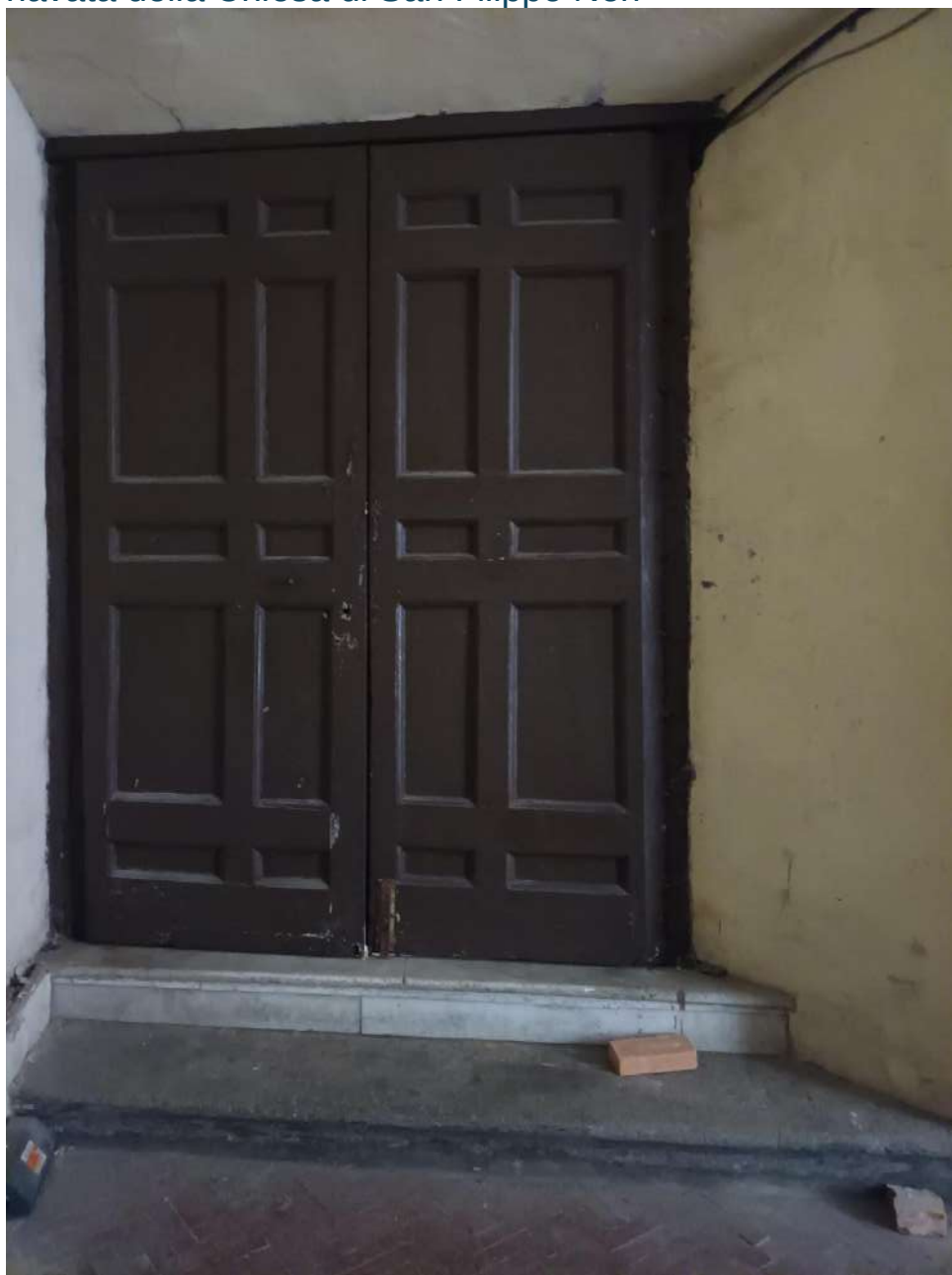
Immagine che mostra i gradini visti in direzione della Chiesa
