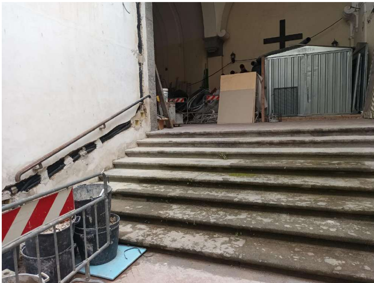
Immagine che mostra la rampa di gradini con visibile il corrimano
