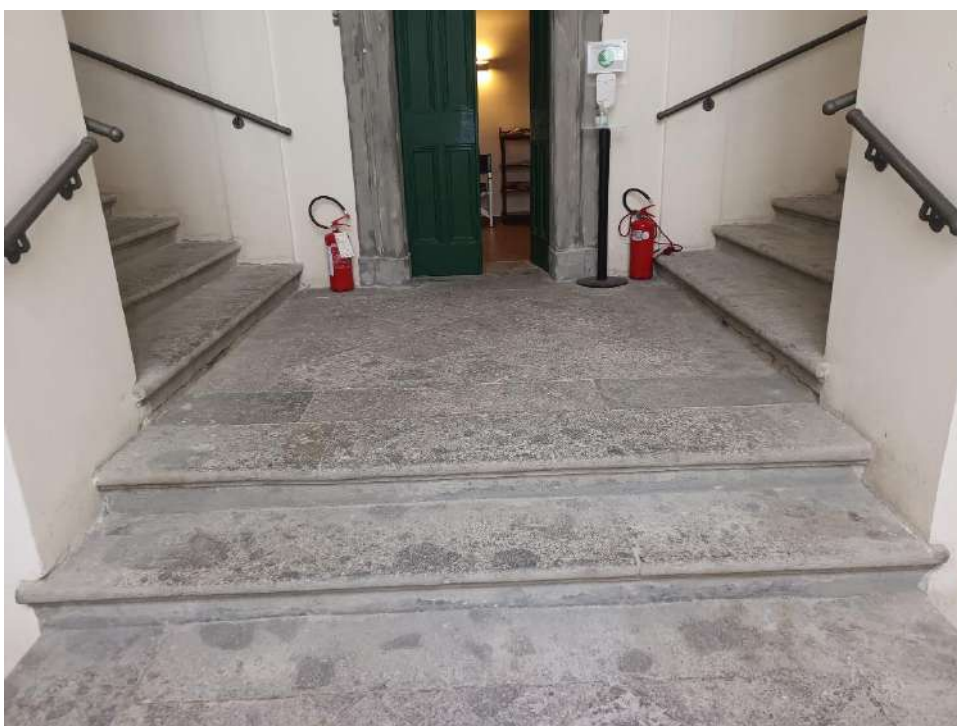
Immagine che mostra la terza rampa di gradini che compone la scala. Anche in questo caso si notano i corrimani sia su questa rampa che su quelle successive speculari tra loro. Questa rampa è l'unica della scala a non avere un omologo speculare.
